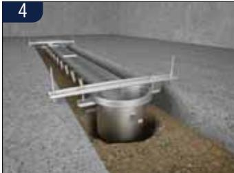
**D** Biegen Sie die Maueranker nach unten.
