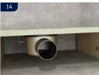
**(PL)** Instalacja wpustu w podłodze wykonanej z drewna poprzez przymocowanie górnej i dolnej części za pomocą długich śrub. Odegnij kotwy do pozycji 90 st. Oznacz oraz wywierć dwa otwory Ø5 mm w podłodze, dopasuj dwa otwory w górnej części umieszczone dokładnie nad kotwami. Przymocuj górną część do dolnej części używając długich śrub dołączonych do wpustu. Kontynuuj instalację od punktu 3 i potem przez kolejne punkty.
