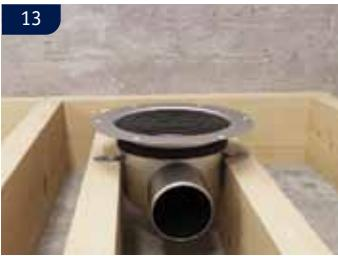
**(PL)** Instalacja wpustu w podłodze wykonanej z drewna z kotwami zamocowanymi do belek. Odegnij kotwy do pozycji 90 st. Wypoziomuj dolną część do belek. Kontynuuj instalację od punktu 3 i potem przez kolejne punkty.
